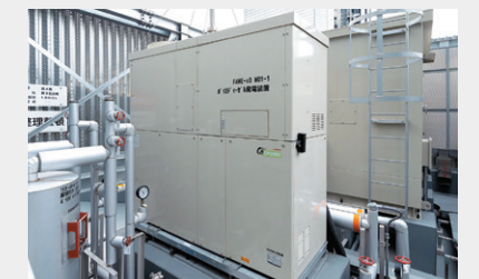
小型バイオディーゼル発電のマイクロコジェネレーション
