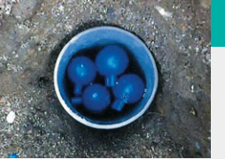
地中熱探熱管挿入完了状況
