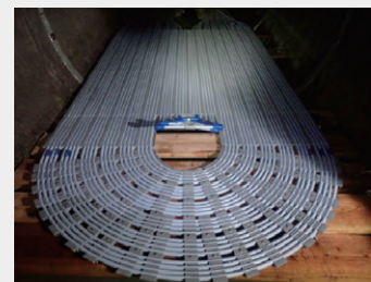
下水本管底部の下水探熱パイプ敷設状況
